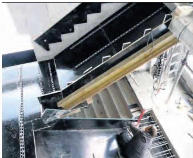
Blick in das Treppenhaus, in dem die Arbeiten in vollem Gange sind. Natürlich gibt es auch einen Aufzug.
